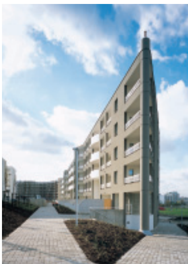
3. cena v soutěži Fasáda roku 2002, kategorie Novostavba Bytový objekt „I“, Praha 9-Černý Most
