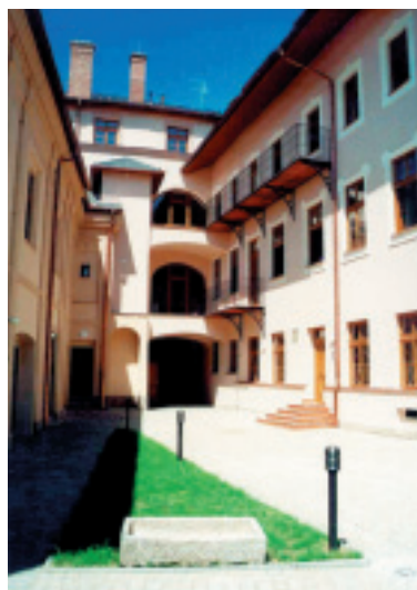
Zvláštní uznání poroty v soutěži Fasáda roku 2002, kategorie Rekonstrukce Bytový dům, Olomouc
