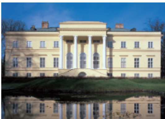
2. cena v soutěži Fasáda roku 2002, kategorie Rekonstrukce Zámek Kinských, Kostelec nad Orlicí
