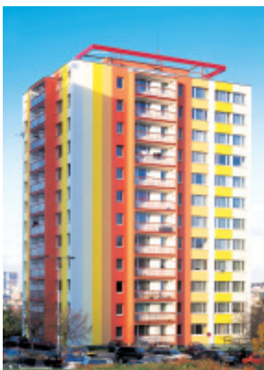
Hlavní cena v soutěži Fasáda roku 2002, kategorie Rekonstrukce prefabrikovaného domu Bytový panelový dům, Praha 10-Zahradní Město
